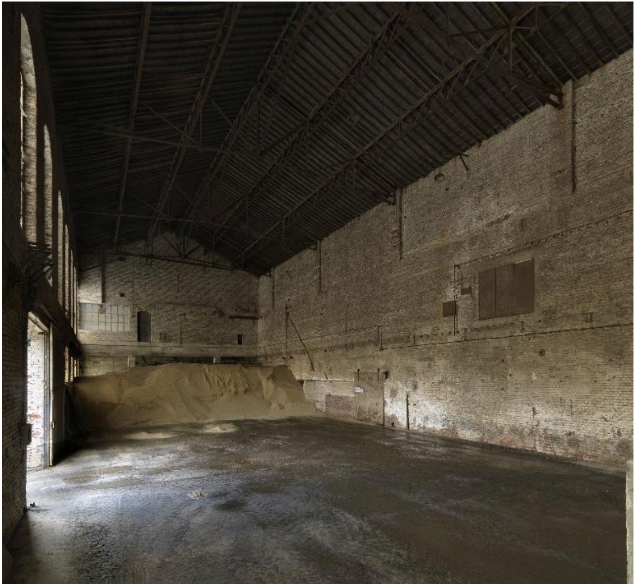
Intérieur de l'atelier de fabrication, vue vers l'ouest.
