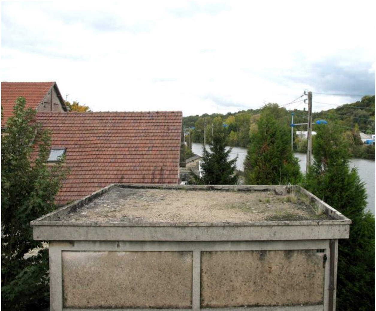
Toit terrasse du transformateur.
