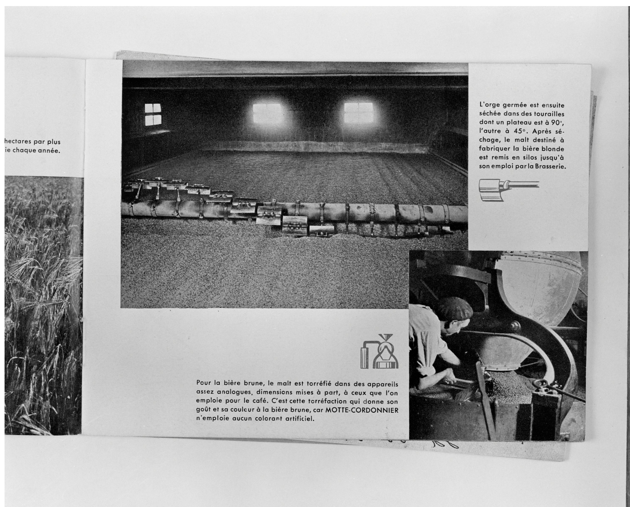
Page 5, intérieur d'une touraille pour malt à bière brune. Brasserie Motte Cordonnier, plaquette éditée à l'occasion du tricentenaire, Paris, 1951 (coll. part.).
