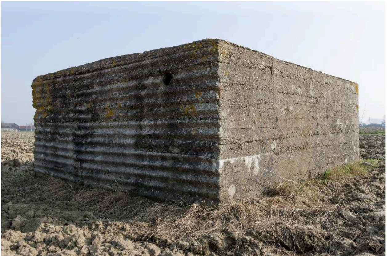
Vue de trois-quarts vers le sud-est
