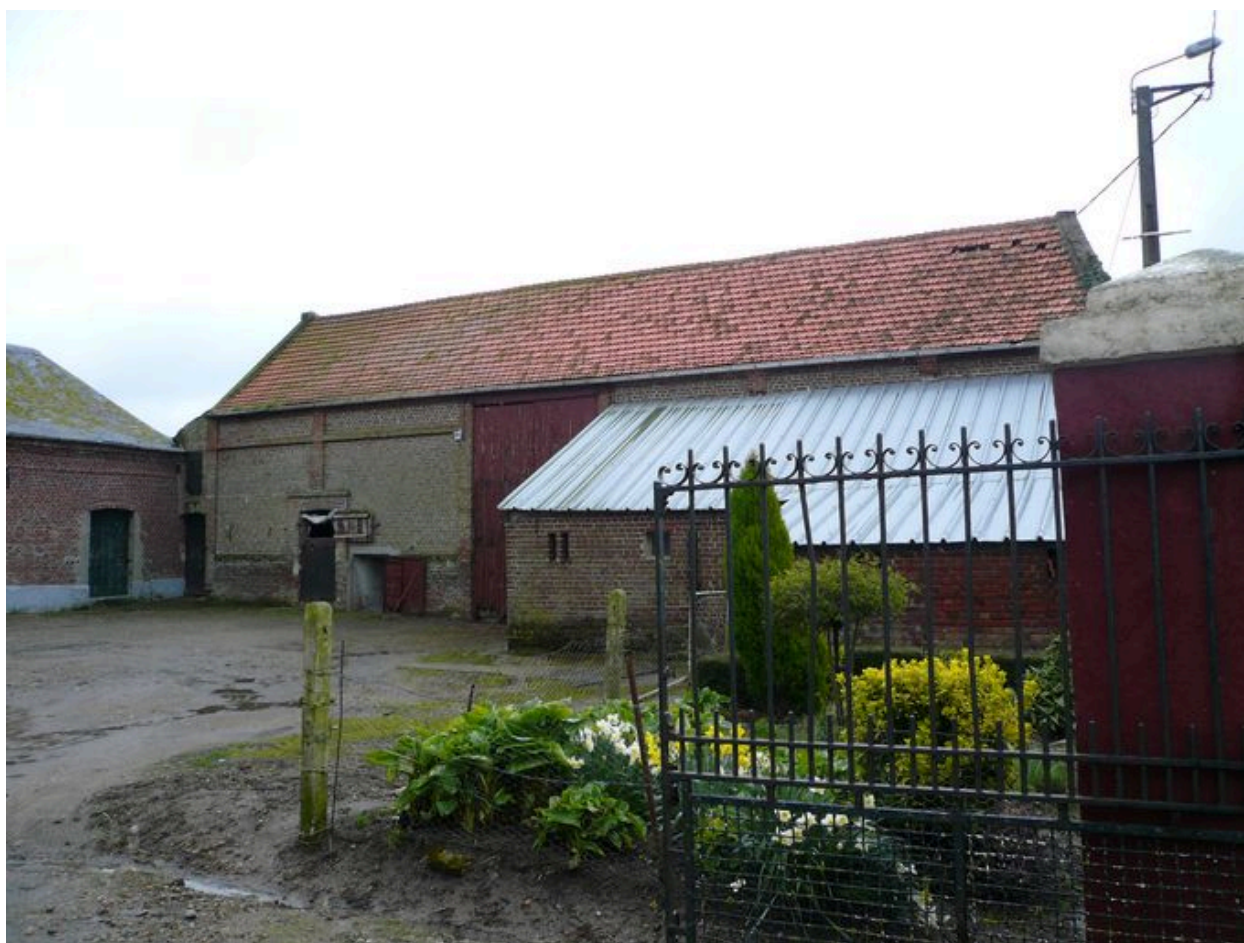
Vue de la grange.
