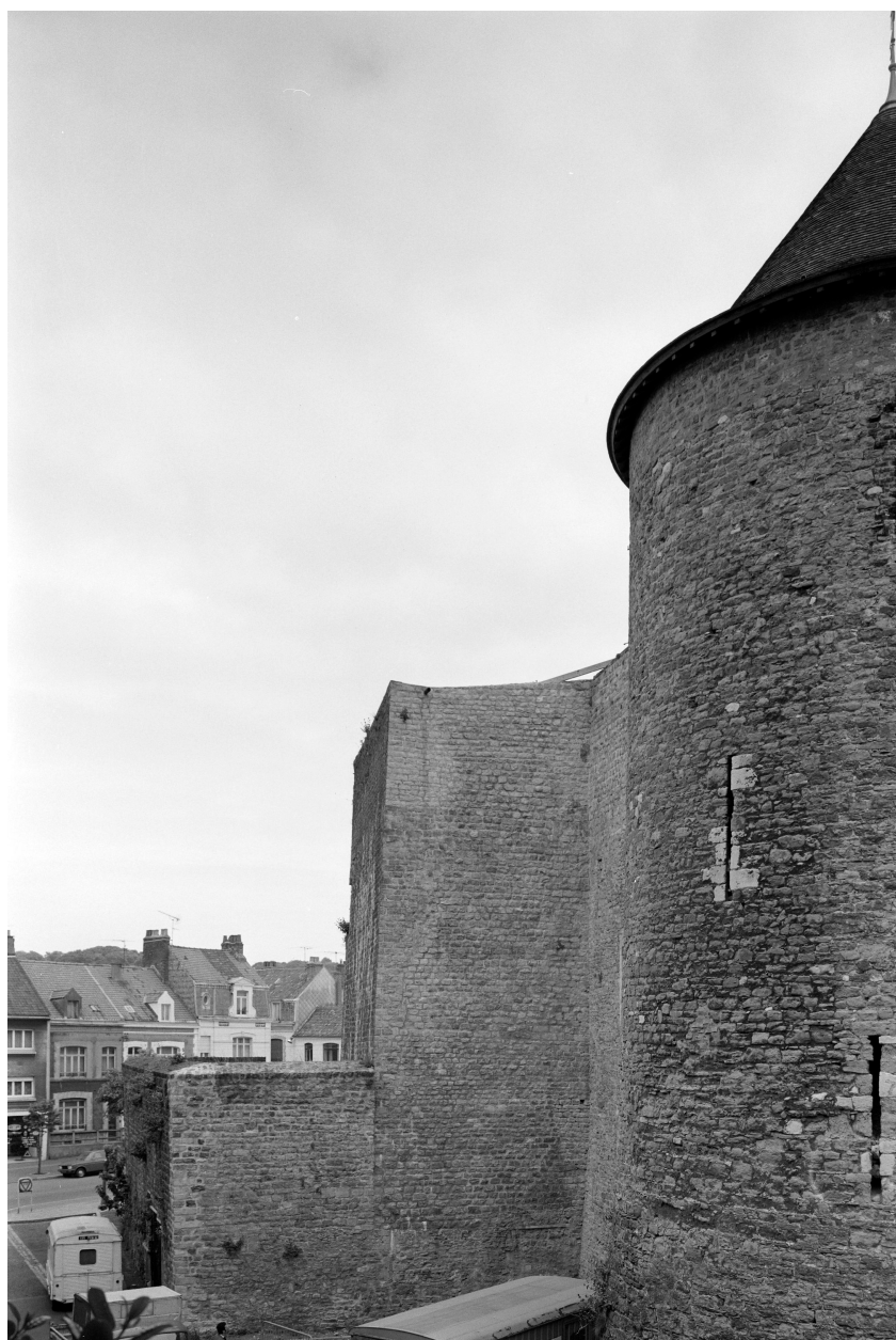
Angle nord, vue de la rue de Bernet.
