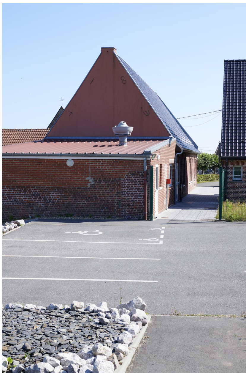
Pignon ouest et arrière du bâtiment. Date partiellement visible sur les fers d'ancrage (18??).
