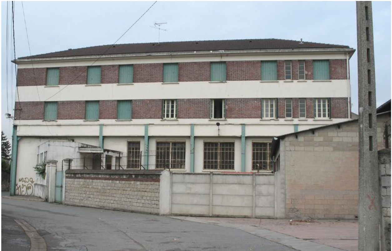
Pignon sud du lycée Gournay.
