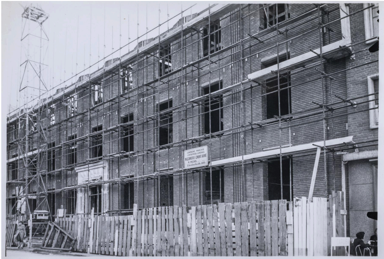
Dunkerque. Succursale de la Banque de France. Façade en construction, photographie noir et blanc, [ca 1953] (AC Dunkerque, fonds Morel (non coté)).
