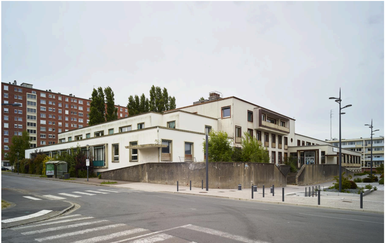
Vue générale du bâtiment depuis le sud-est.
