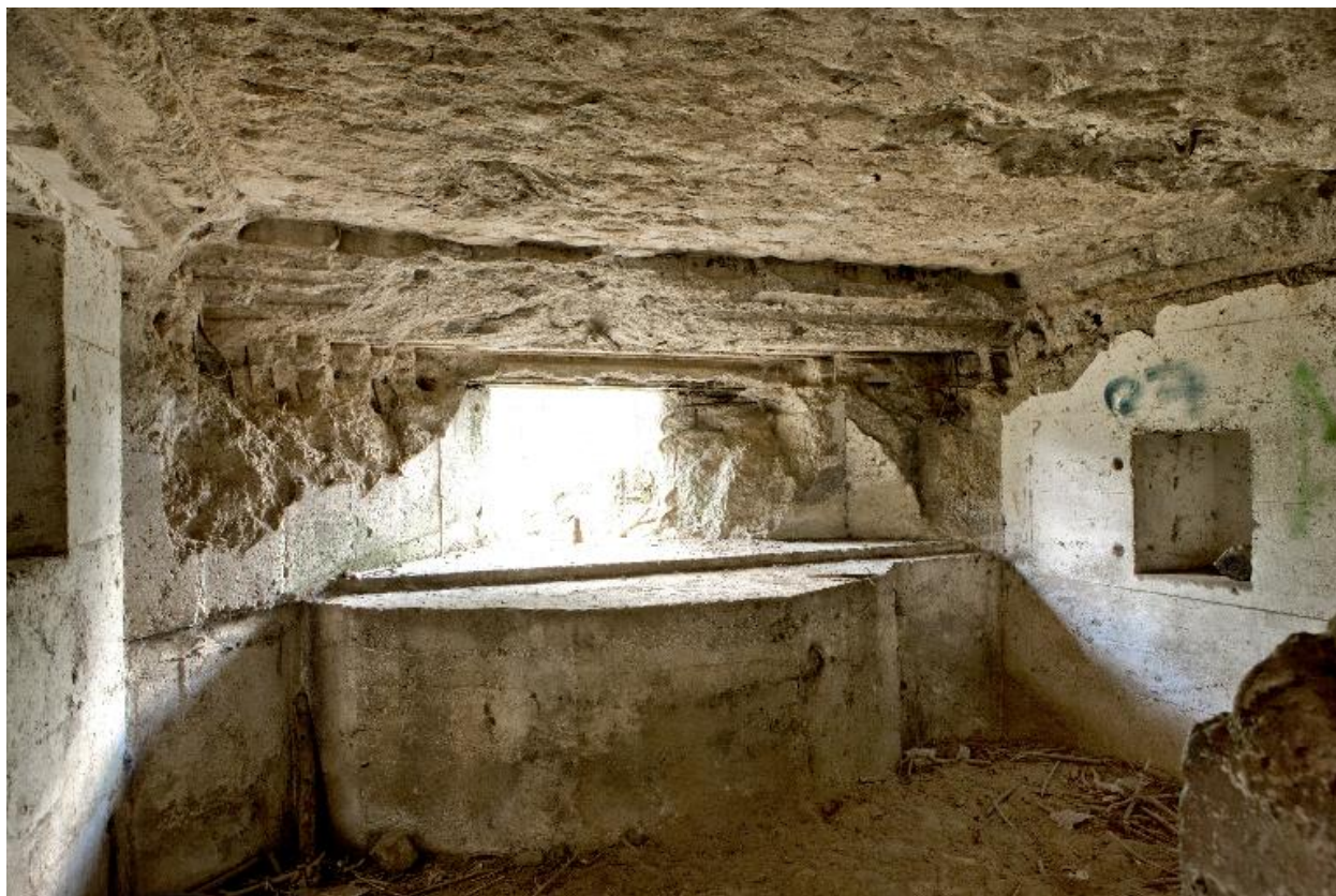
Ouverture et banquette de tir.
