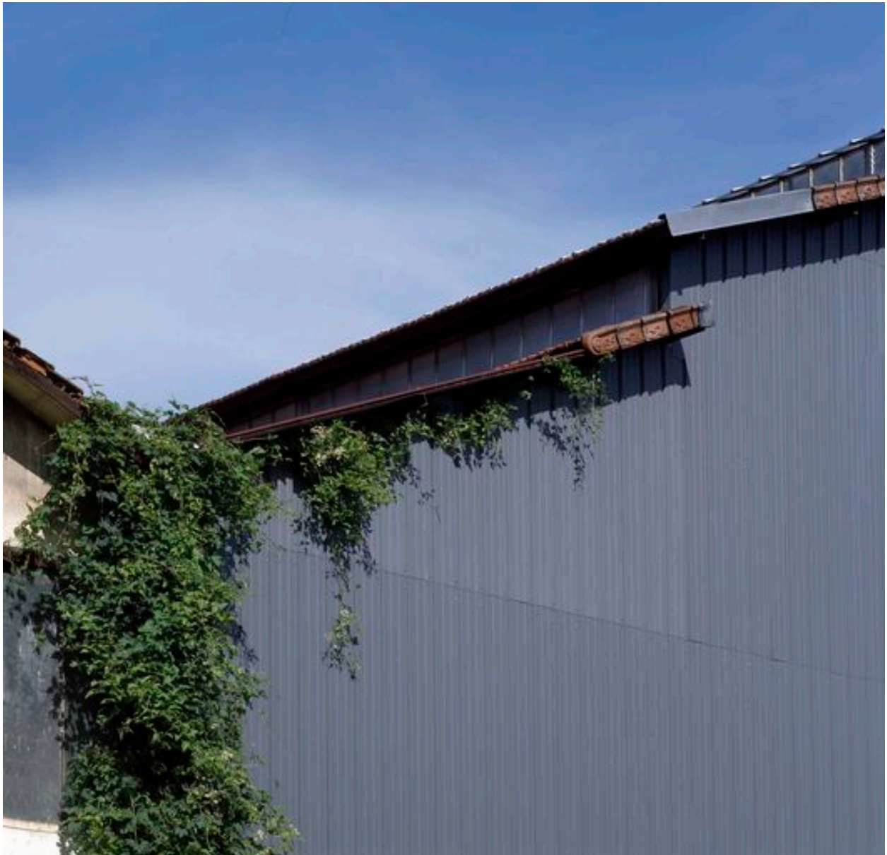
Détail de la bordure de rive de la feutrerie.
