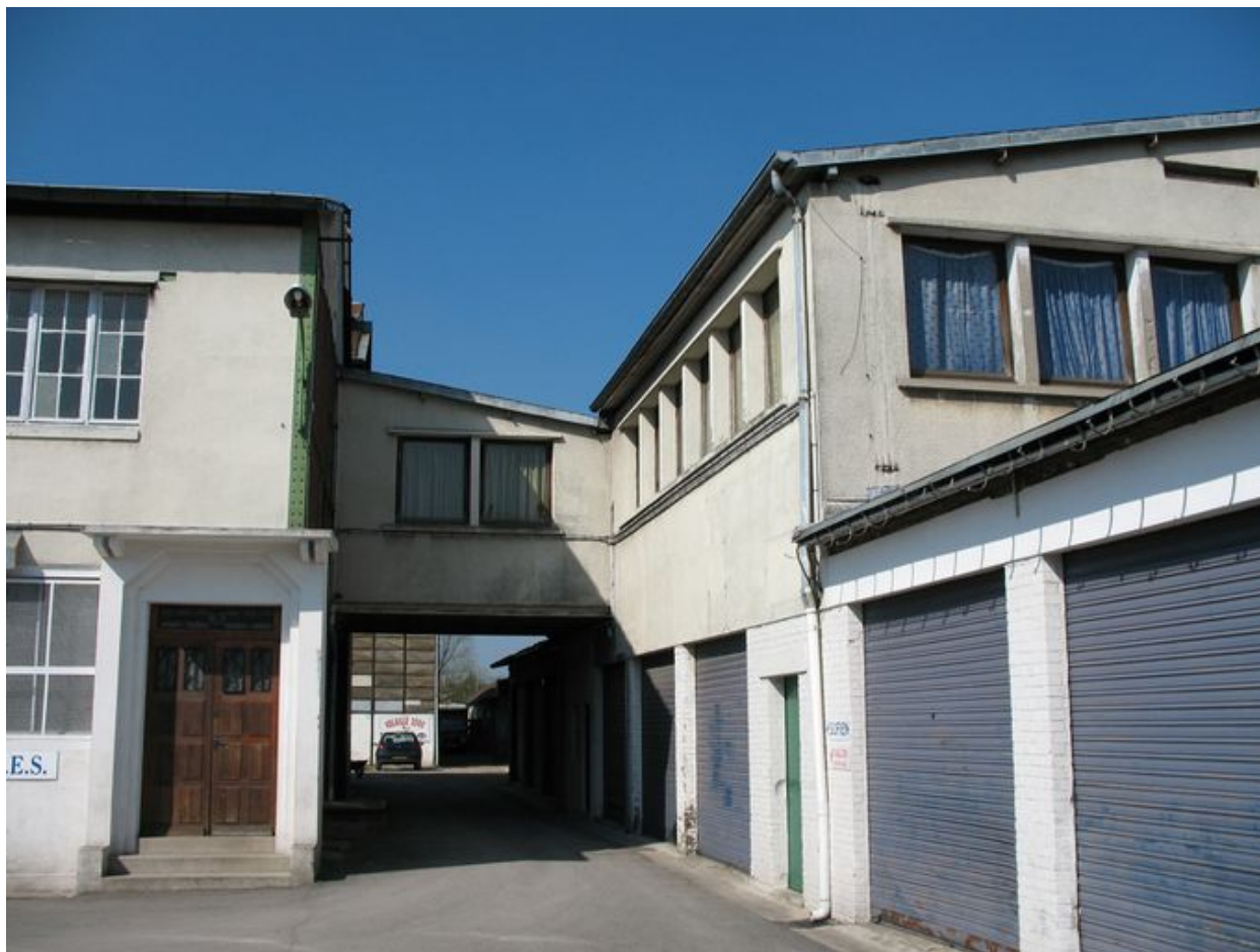
Jonction entre les ateliers de fabrication et les bureaux à l'est.
