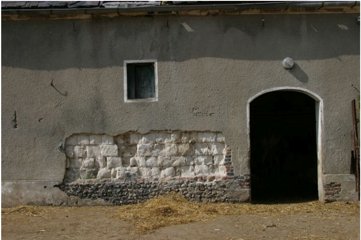
Détail de la maçonnerie de ce bâtiment.
