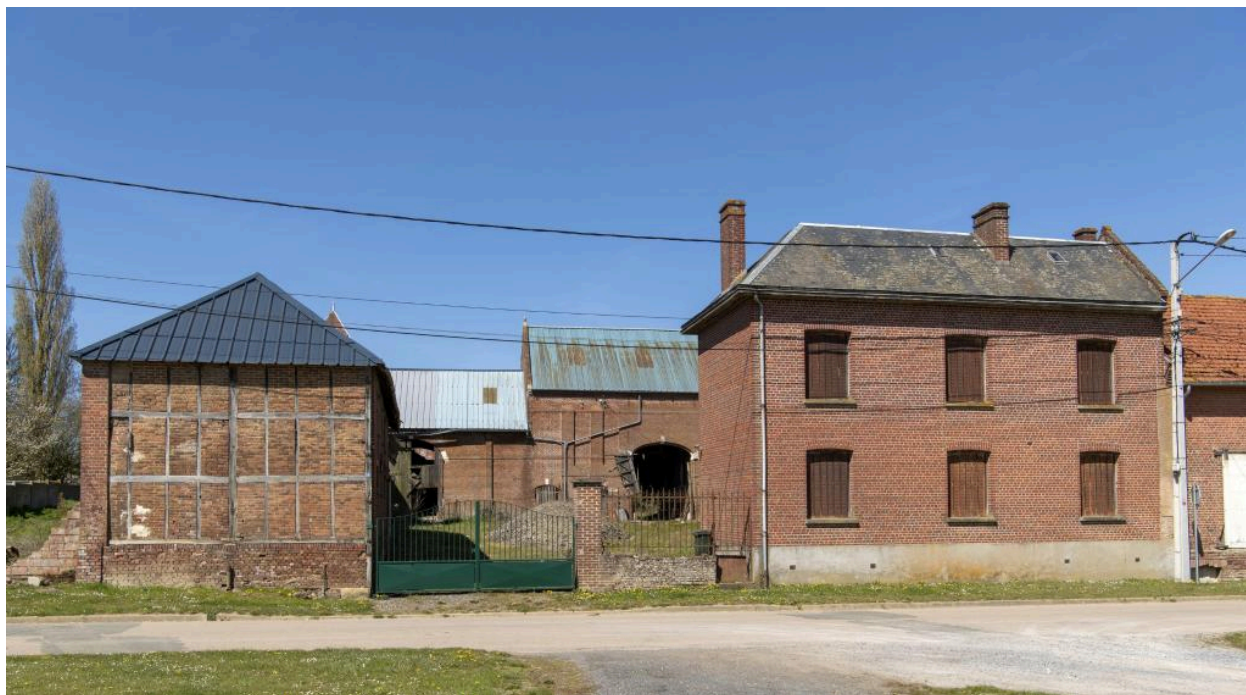
Ferme avec logis sur rue et bâtiments agricoles, n°38 rue Principale, vue depuis l'est.
