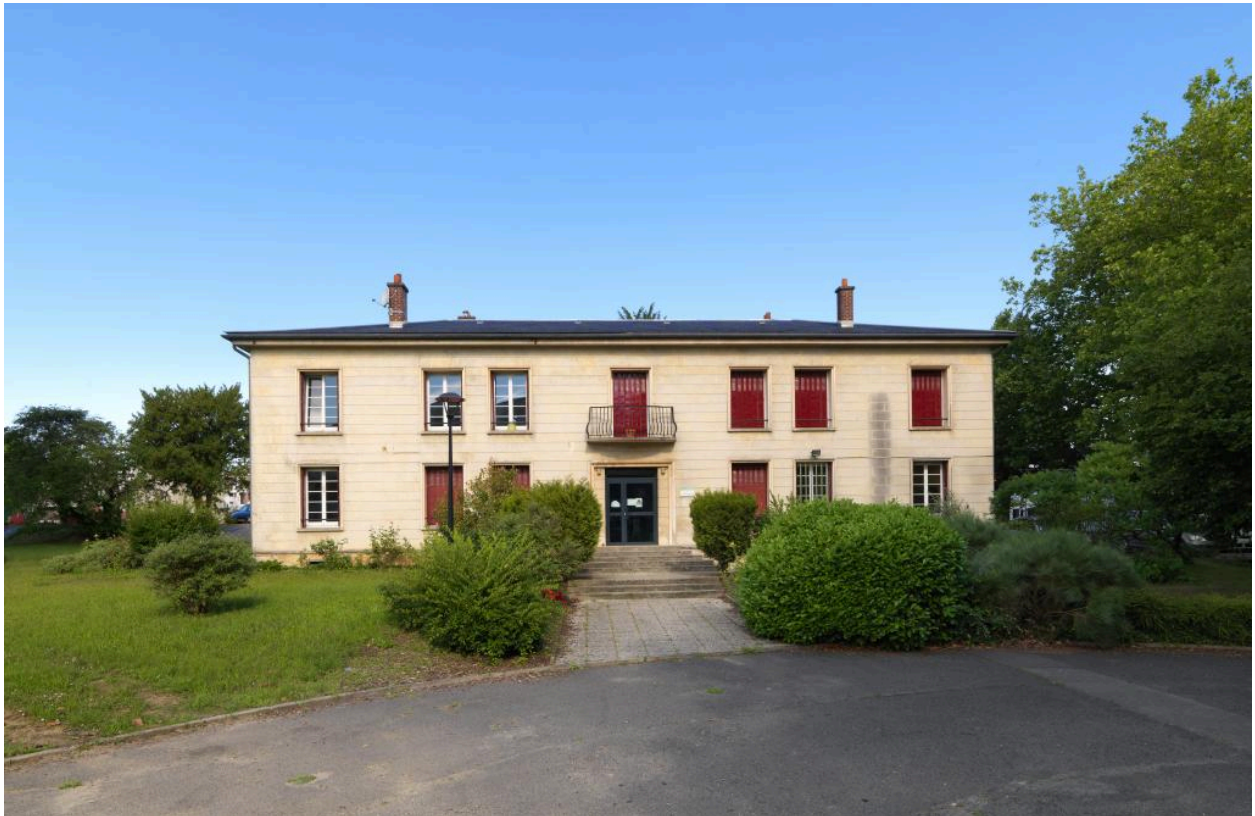
Bâtiment administratif du collège, façade est, vue de face.
