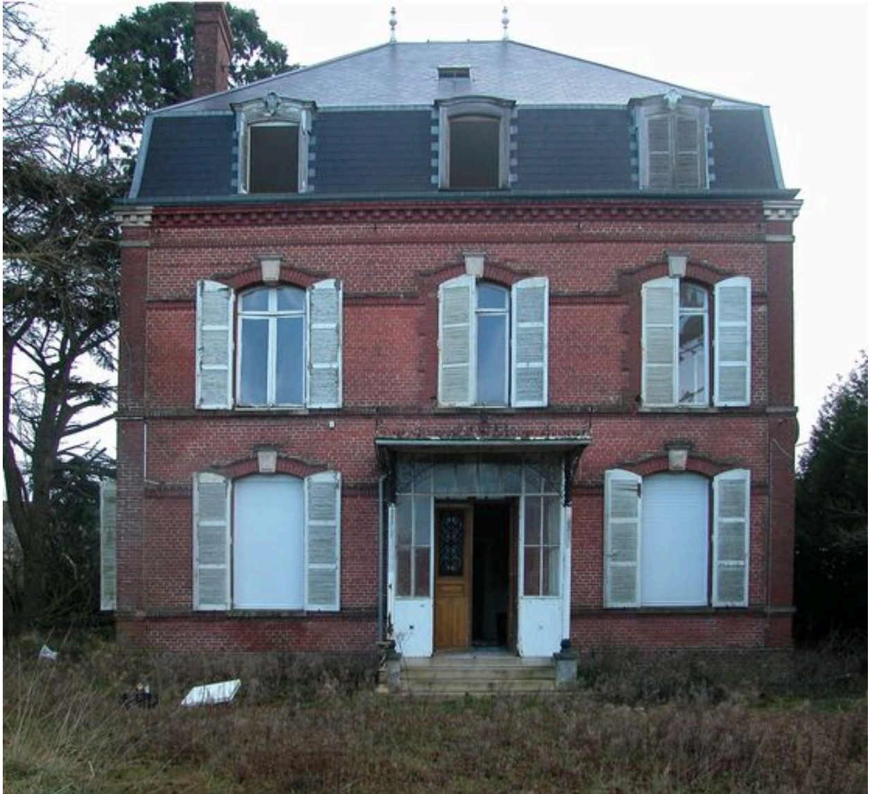
Le logement du directeur, vue de face.
