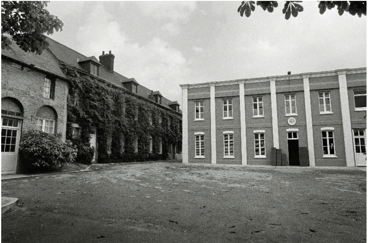
Elévation antérieure des bureaux, en 1990.
