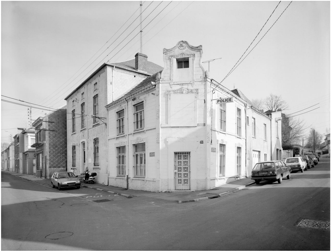
Vue frontale de l'élévation.
