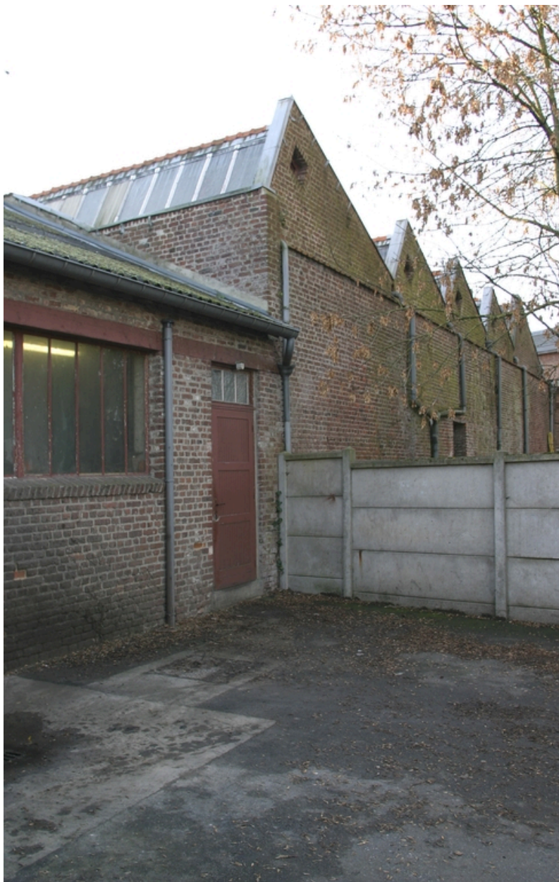
Façade postérieure des ateliers.
