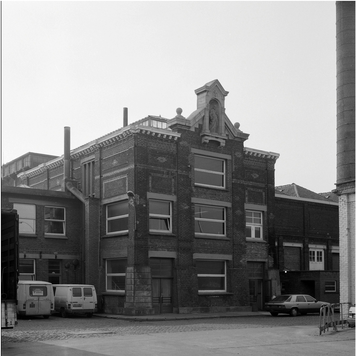
Salle des machines, vue extérieure.
