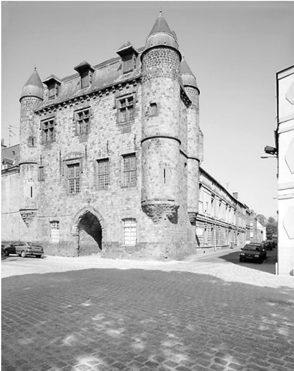
Corps de bâtiment médiéval et enfilade de l'aile sur la rue de la Bibliothèque : état en 2001.
