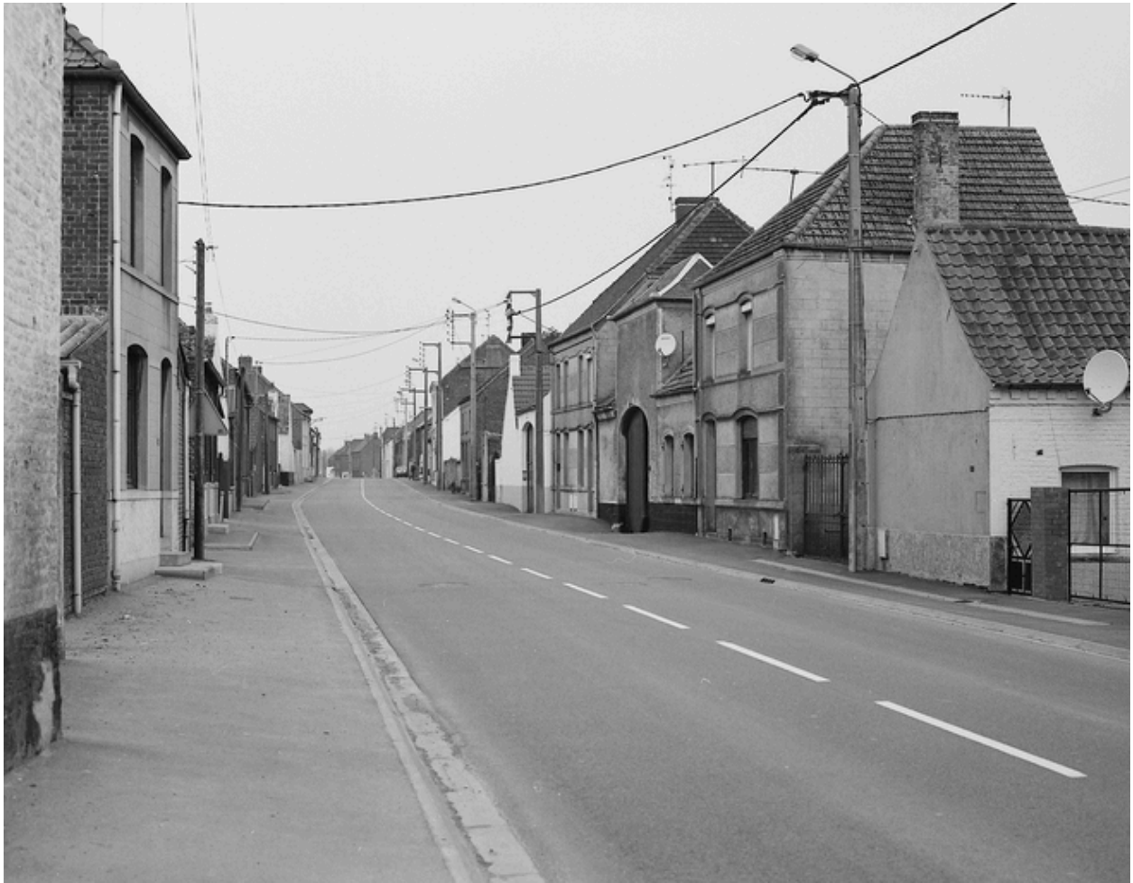
Vue générale de la Grand'rue.
