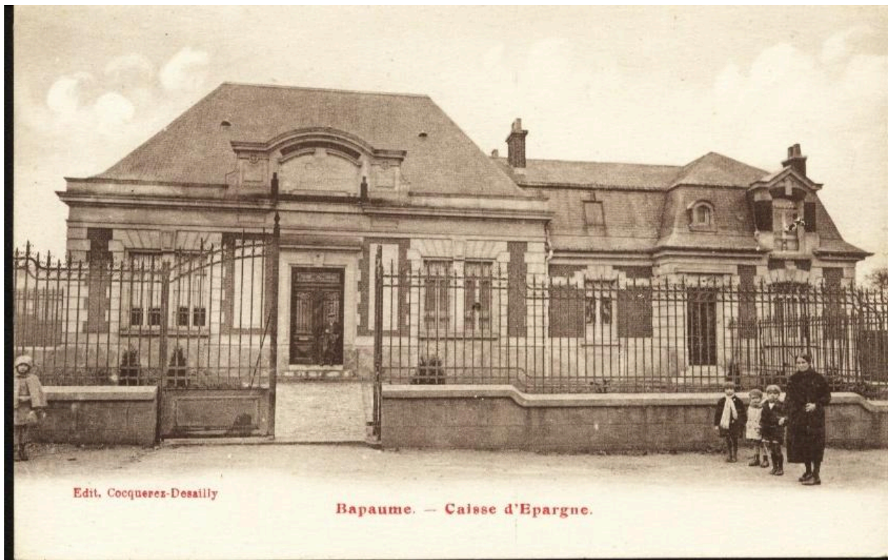
Bapaume - Caisse d'Épargne. Editions Coquerez-Dessailly. Carte postale, vers 1930 (coll.part.). Façade principale et mur-bahut sur la rue de la république.
