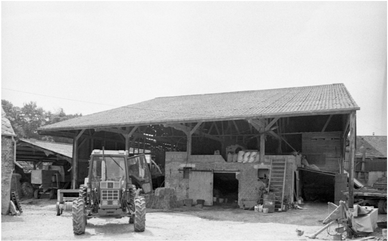
Vue d'ensemble de l'élévation sur cour de la grange.
