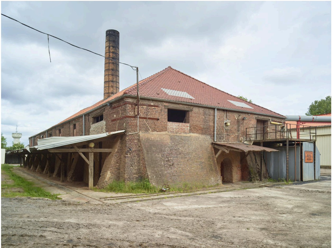
Four Hoffmann. Vue de trois quart prise vers le nord-ouest.
