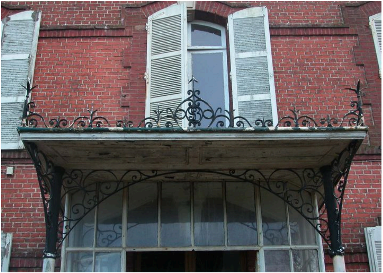
Détail de la marquise en fer forgé du logement patronal.
