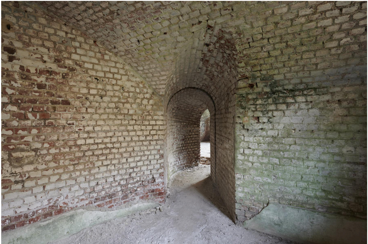
Sous-sol de caserne de gorge. Caserne de flanquement est. Couloir d'accès à la deuxième salle.
