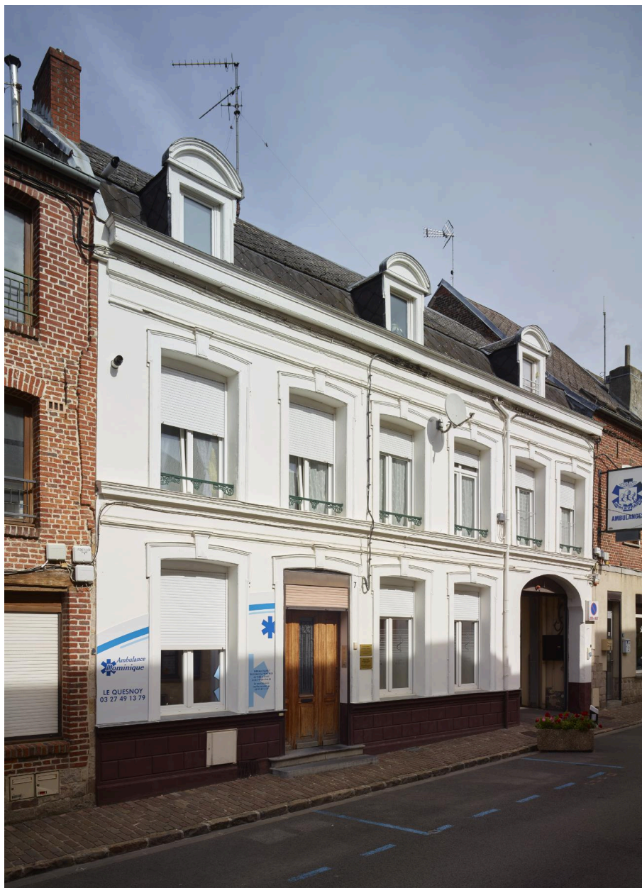
Maison de maître avec porte bâtarde et porte cochère - 7-9-11, rue Jean Jaurès.
