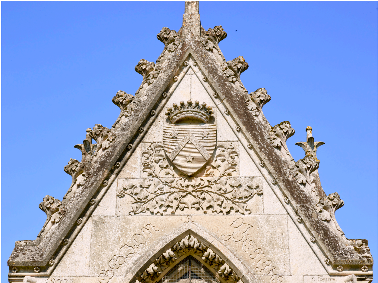
Détail de l'ornementation de l'élévation est.
