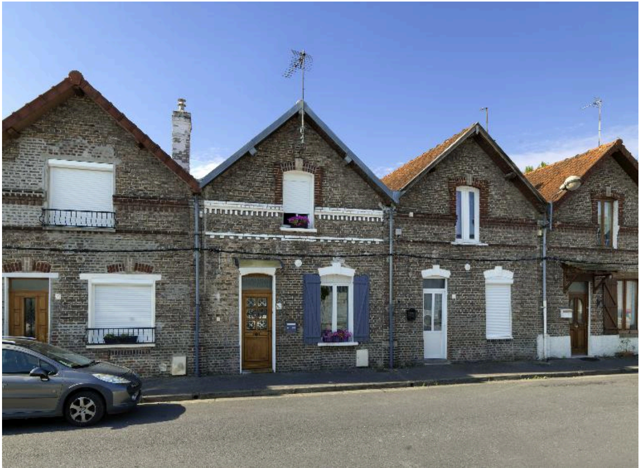
Logements ouvriers de la rue Nouvelle-Cité-Saint, façades des n° 19, 21 et 23.
