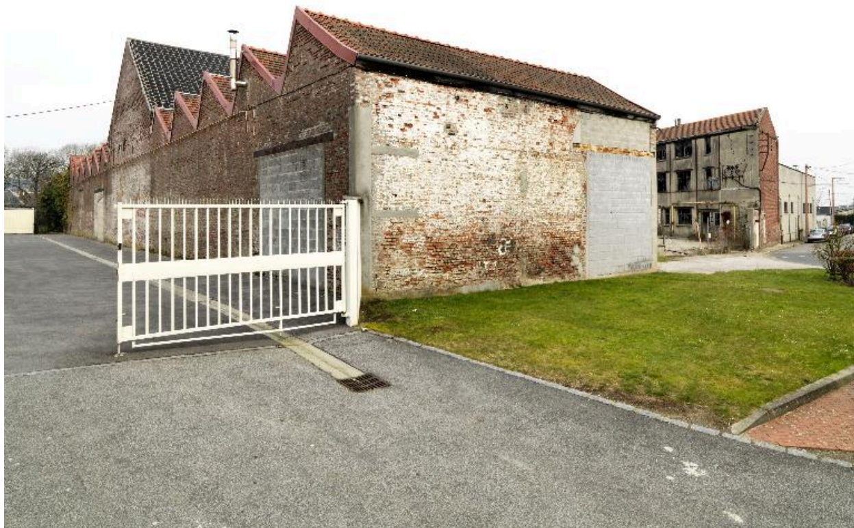
Atelier de fabrication, flanc nord.
