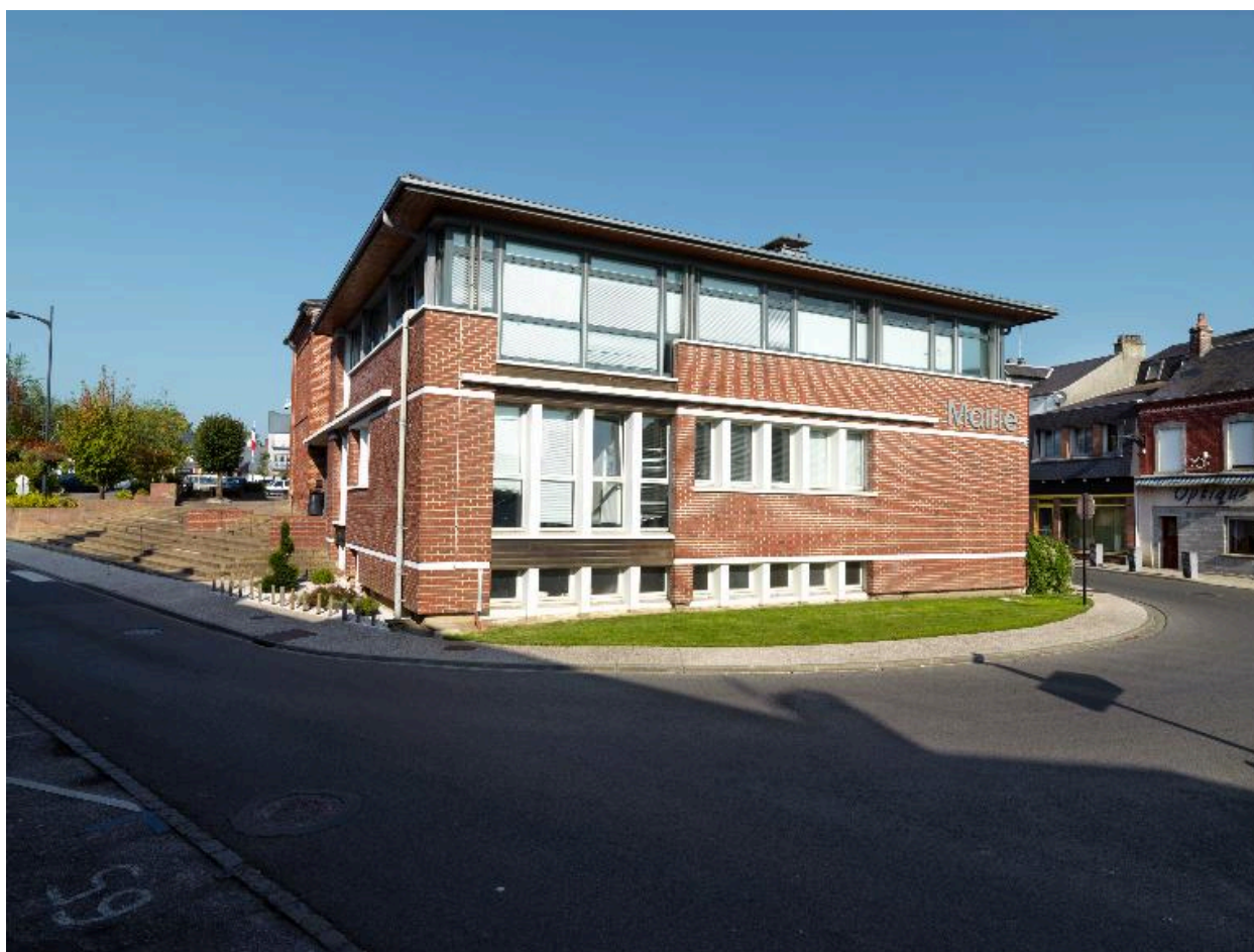
Vue des extensions de la mairie d'Escarbotin.
