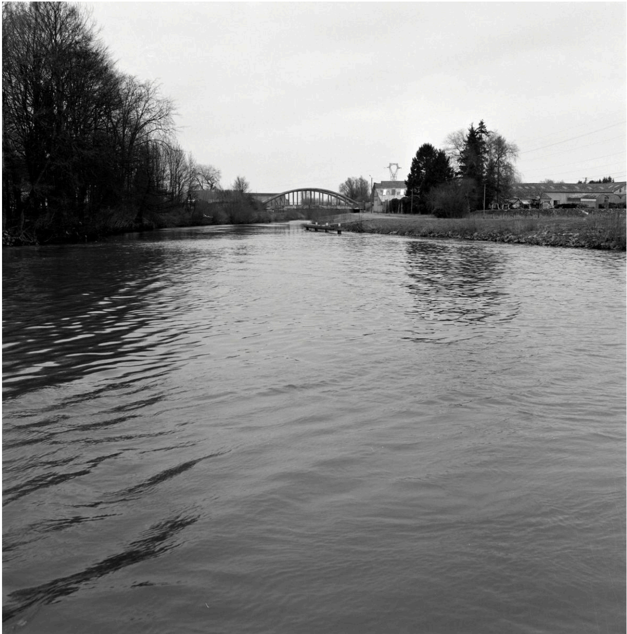
Vue générale du pont en béton reliant Berlaimont à Aulnoye-Aymeries.
