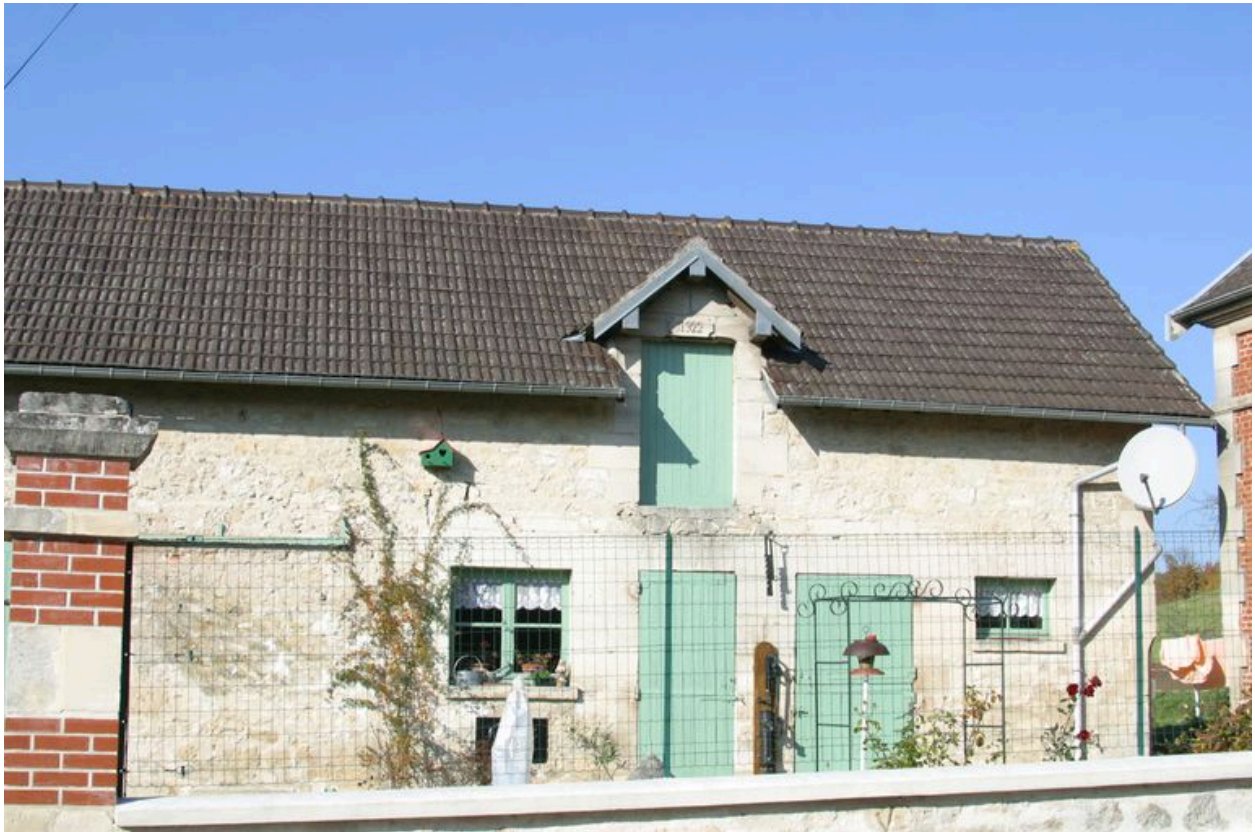
Vue générale de la grange.
