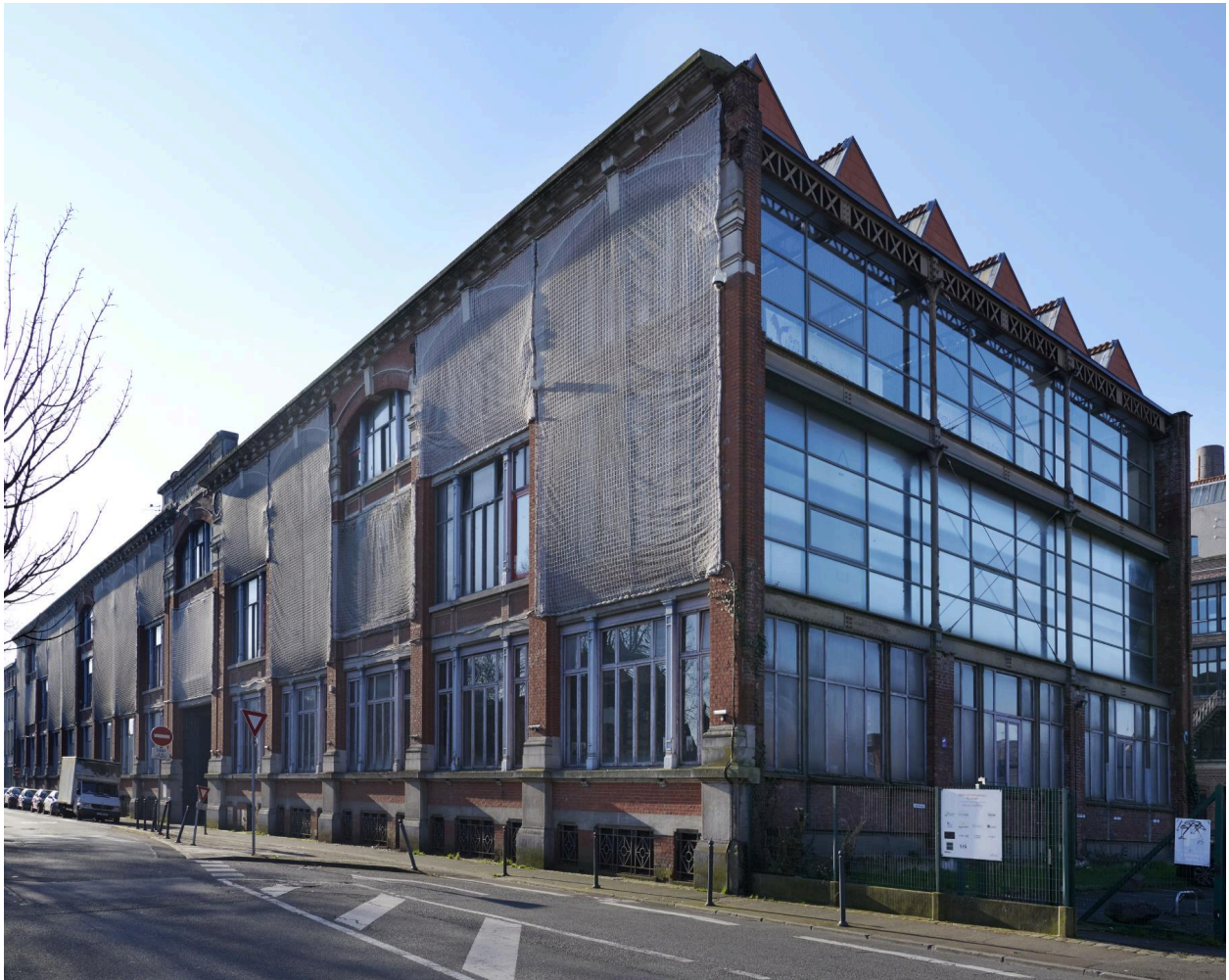
Vue générale, trois quarts nord-ouest.
