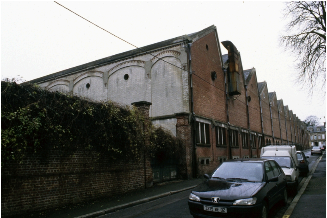
Enfilade des pignons en shed des ateliers fabrication (rue des Faucons, 2001).
