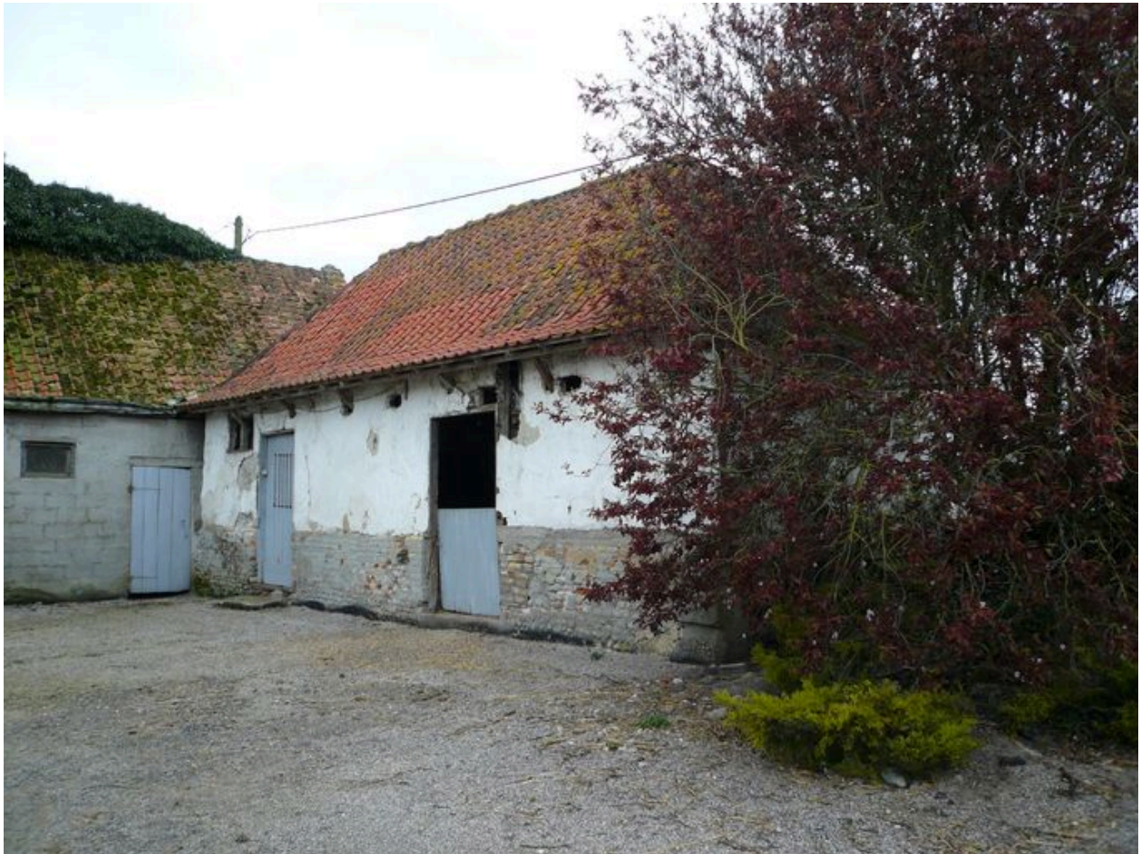
Vue de la bergerie au sud-ouest de la cour.
