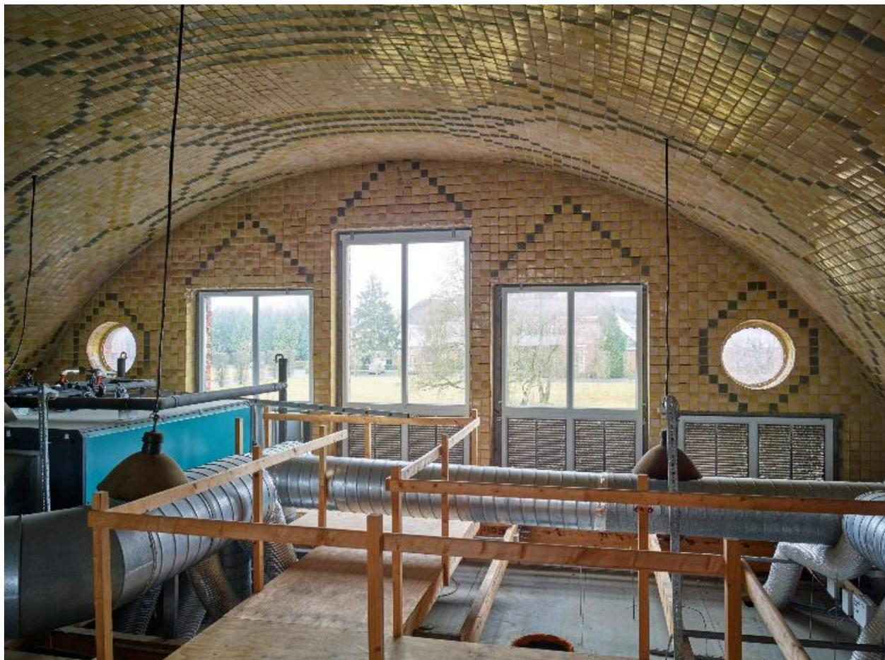
Bâtiment des cuisines, salle centrale actuellement divisée par un plancher, détail du voûtement visible au-dessus de ce plancher, vue vers le revers de la façade antérieure.
