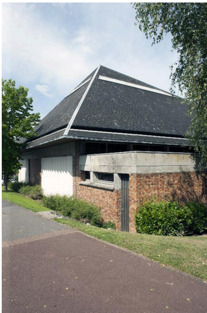
Vue extérieure du flanc droit de l'église.
