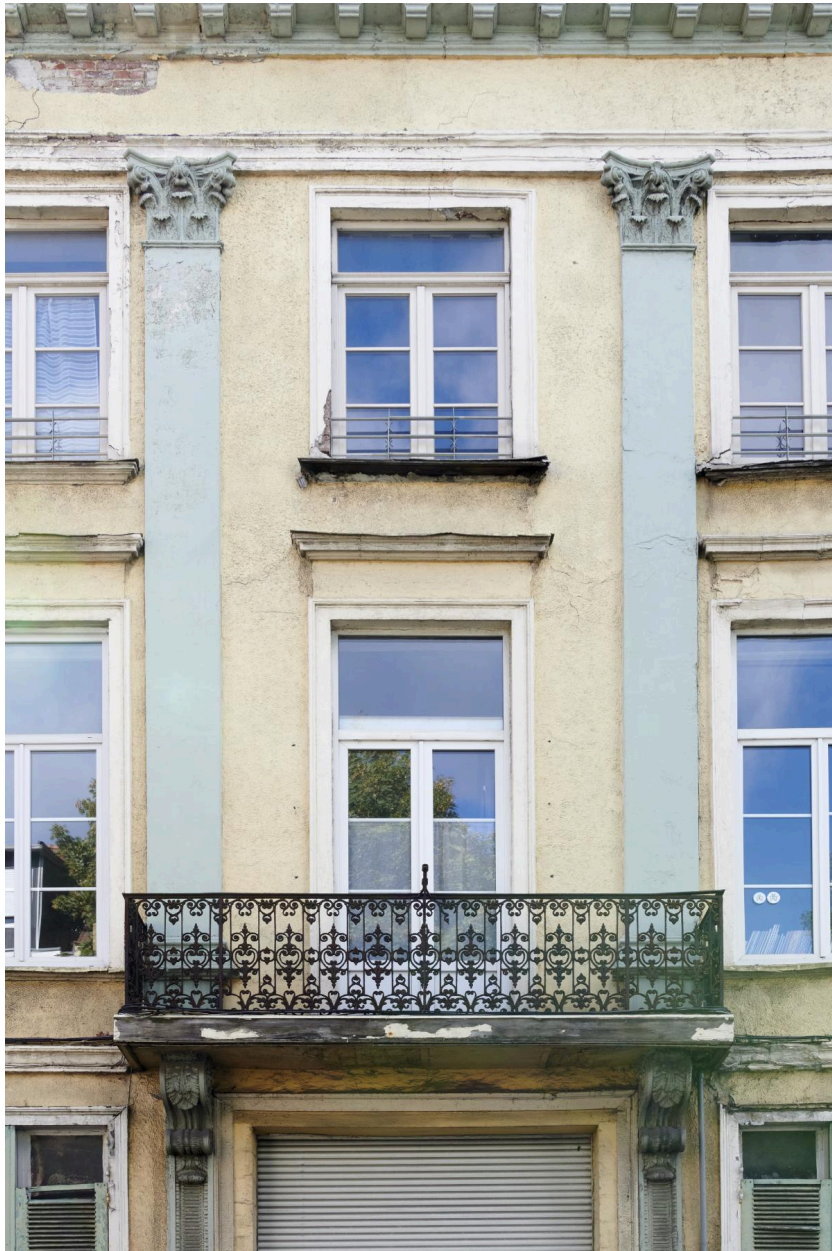
Pilastres corinthiens, balcon de la travée centrale munie d'une rambarde en ferronnerie.
