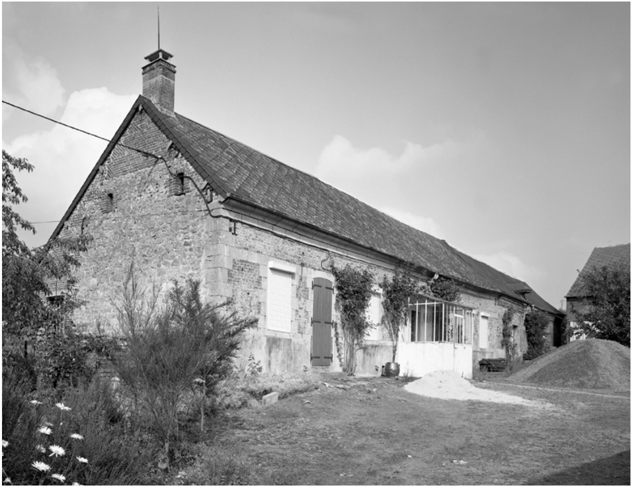
Vue générale ouest du logis et de l'étable attenante.
