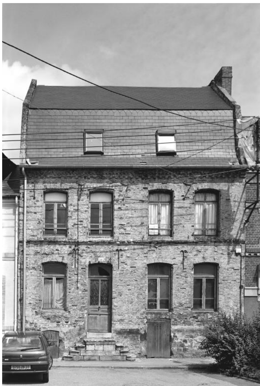
Vue de la façade sur rue.
