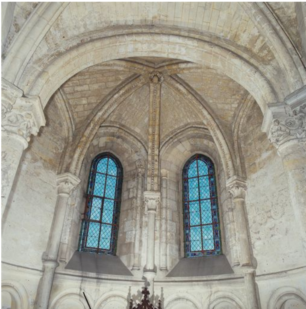
Vue intérieure du déambulatoire, chapelle rayonnante.
