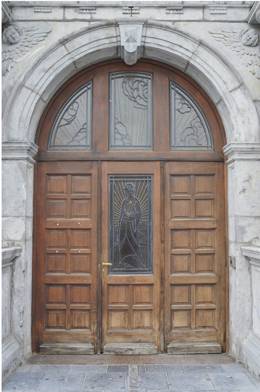
Porte d'entrée avec ses ferronneries.
