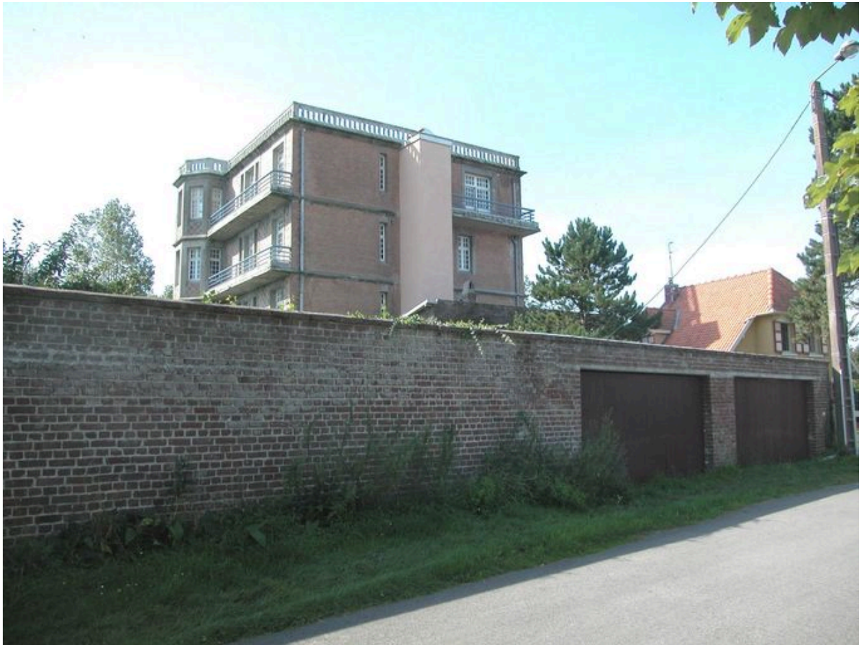
Elévation postérieure et garages, depuis la rue.
