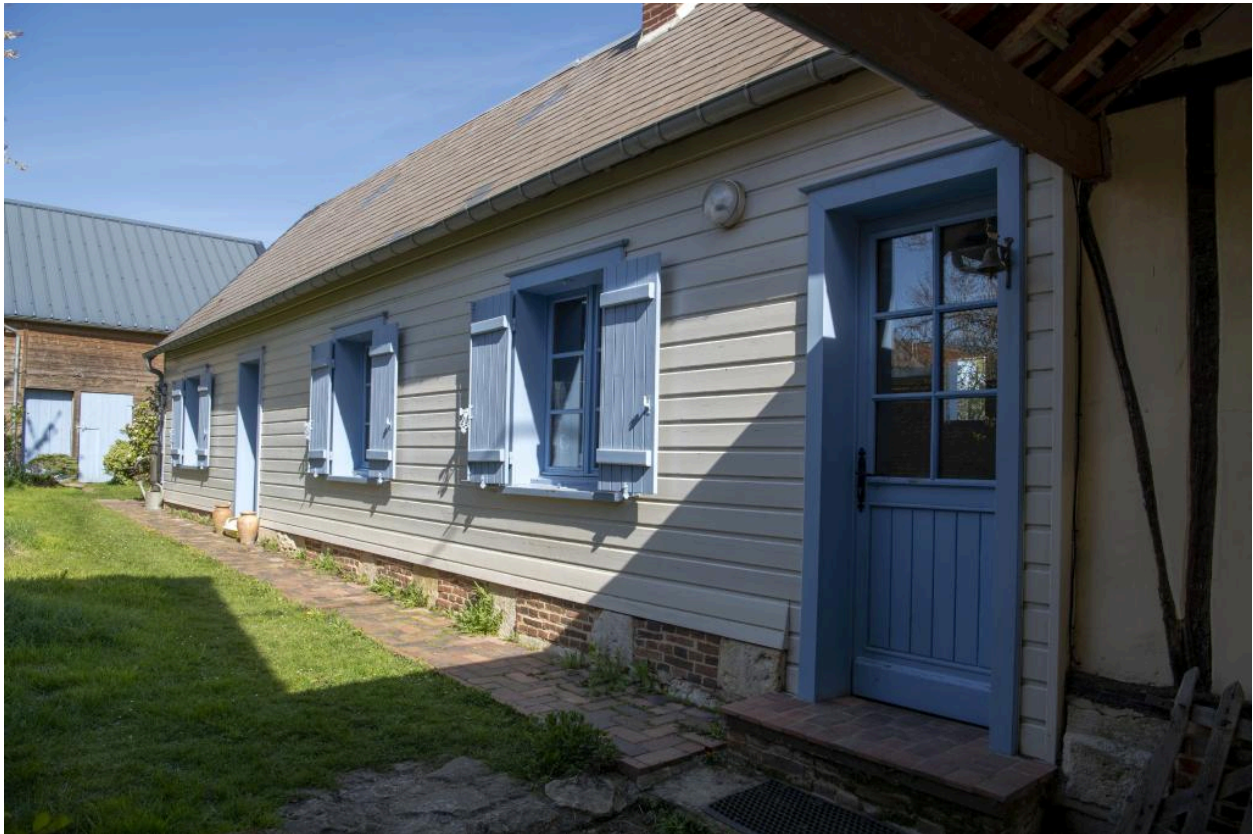
Logis d'un ancien atelier de forgeron (façade sud, côté cour), n°50 rue Principale, vue depuis le sud-est.
