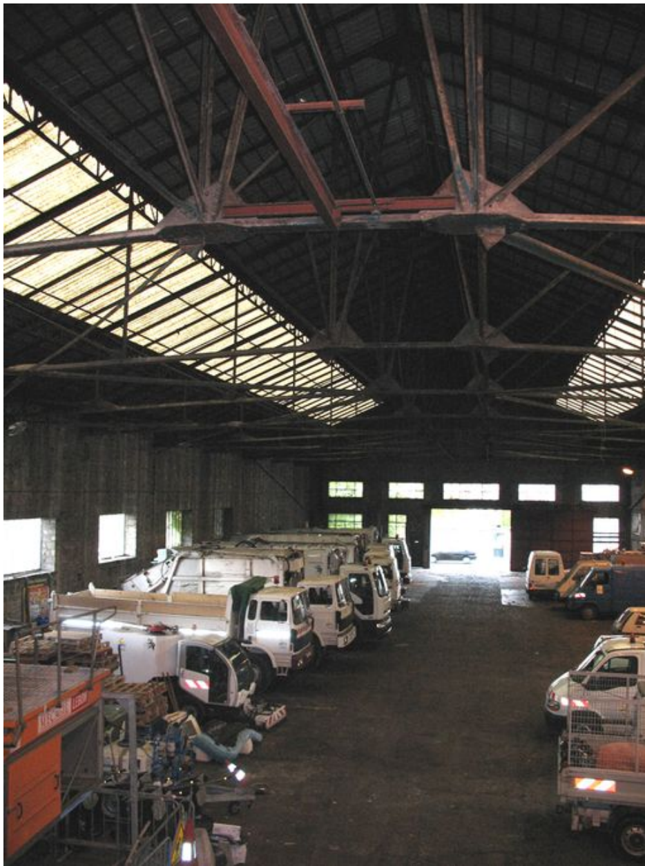
Intérieur des ateliers vu vers le nord.
