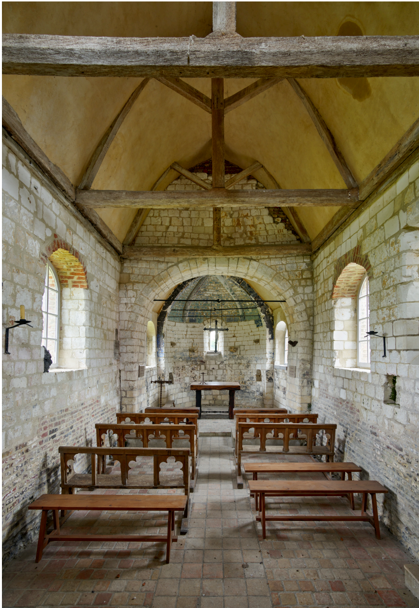
Intérieur, vue depuis l'entrée.
