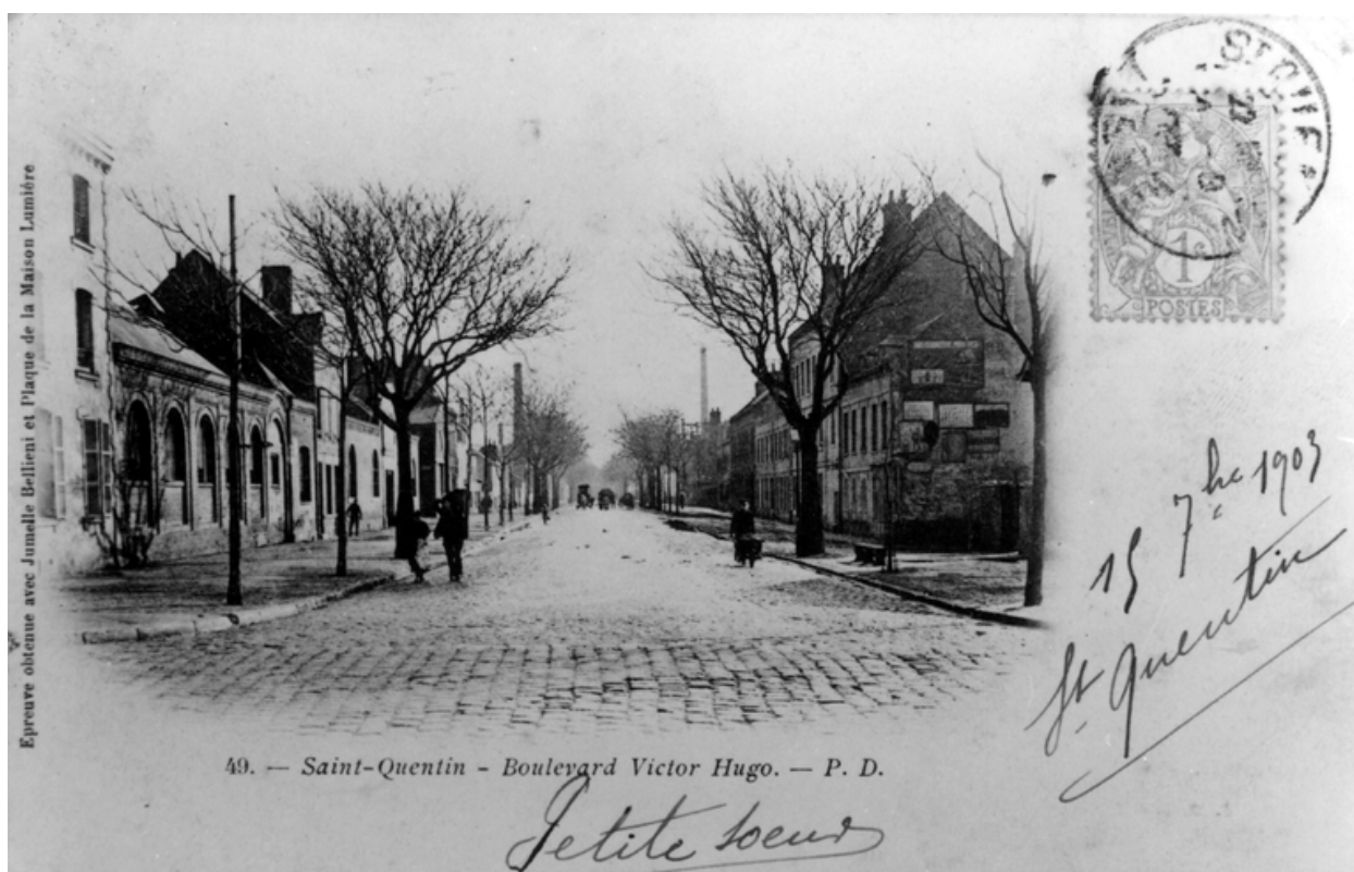
Carte postale, 1903. A gauche, façade des ateliers (6 ouvertures couvertes en plein-cintre), boulevard Victor-Hugo (BM Saint-Quentin).
